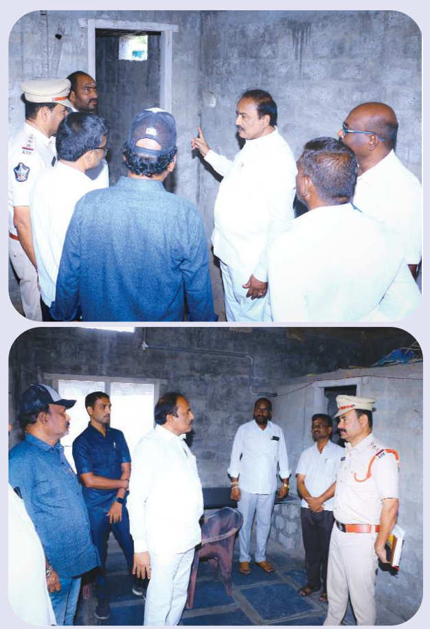
చీరాల, పెన్ పవర్, జూన్ 18 చీరాల మండలం వాడరేవు గ్రామంలో నిర్మిస్తున్న మెరైన్ పోలీస్ స్టేషన్ భవన నిర్మాణ పనులను ఎమ్మెల్యే మద్దులూరి మాలకొండయ్య బుధవారం పరిశీలించారు. సకాలంలో పనులు పూర్తి చేసి అందుబాటులోకి తీసుకురావాలని అధికారులను ఆదేశించారు. ఆర్డీవో చంద్రశేఖర్ నాయుడు, చీరాల రూరల్ సీబి శేషగిరి రావు, వాడరేవు కూలమి నాయకులు పాల్గొన్నారు.
