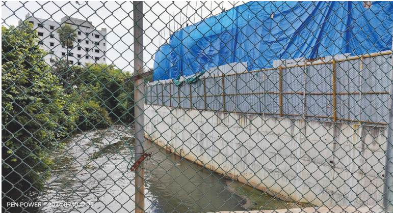
పూర్తి చేసిన అక్రమ కమర్షియల్ నిర్మాణం.. ప్రారంభంలో ఇలా.. 2024 సెప్టెంబర్ 10న.. ఫైల్ ఫోటో..
