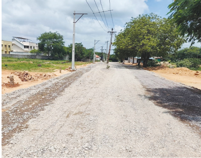
కమిషనర్- తహశీల్దార్ సహకారంతో నిరాటంకంగా రోడ్డు నిర్మాణ పనులు..
