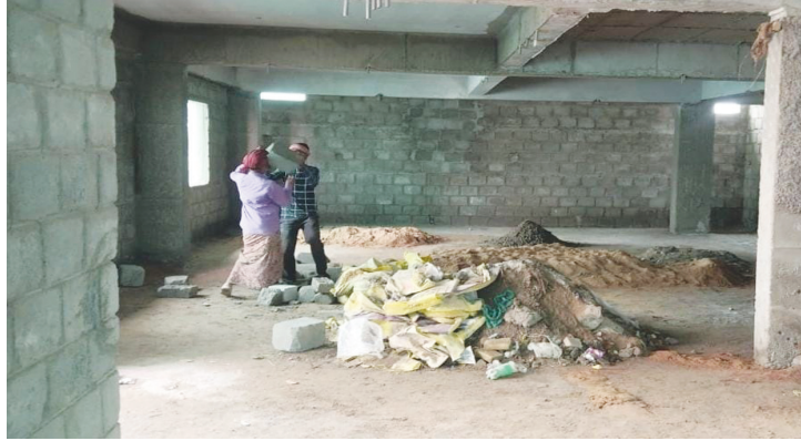
ప్రణీత అక్రమ నిర్మాణంలో పనులు వేగవంతం..
