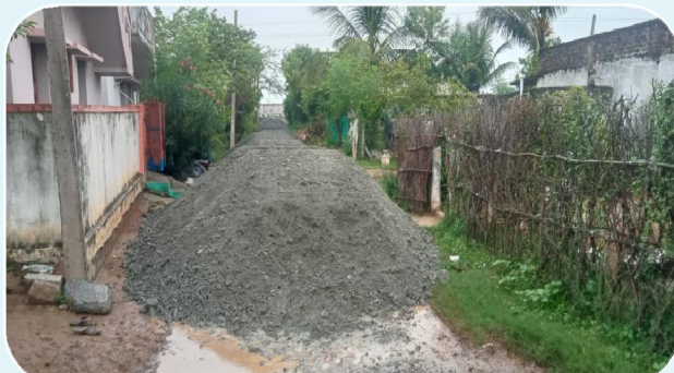
నూతనంగా చేపడుతున్న రోడ్డు పనులు...
