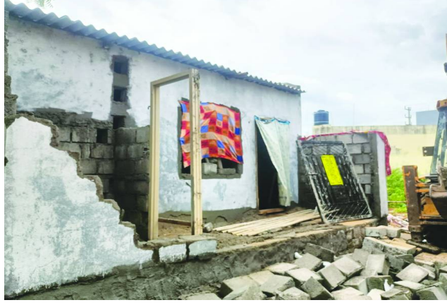
బొరంపేట్ ఇందిరమ్మ కాలనీలో ఆర్ఘ సాజన్యంతో, నాగరాజు నిర్మాణం..
